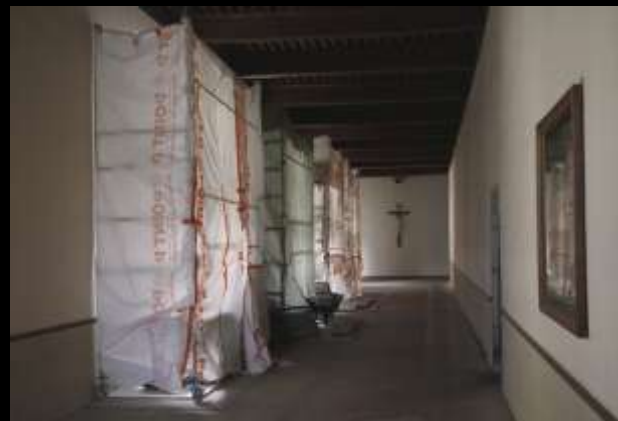
En août le chantier en panne pour cause de congés
