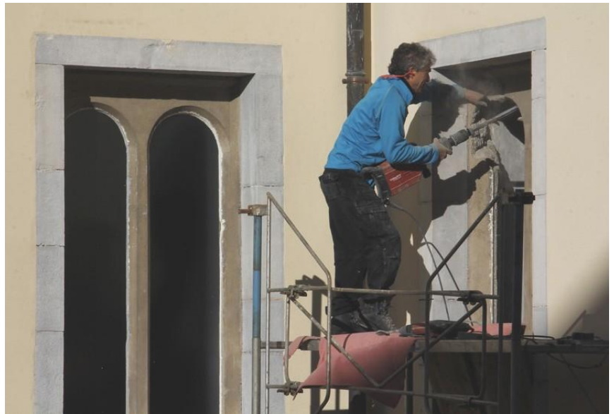
Dépose de la structure en béton datant de 1930
