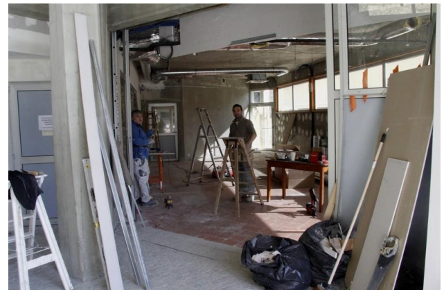
Aménagement d'une salle de conférence
