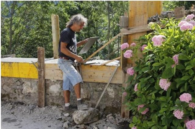
Mohamed démolit une partie du mur de clôture côté Belle-Étoile très abimée par le gel et les ans pour refaire un chaînage à une hauteur plus faible, permettant de dégager la neige par-dessus.
